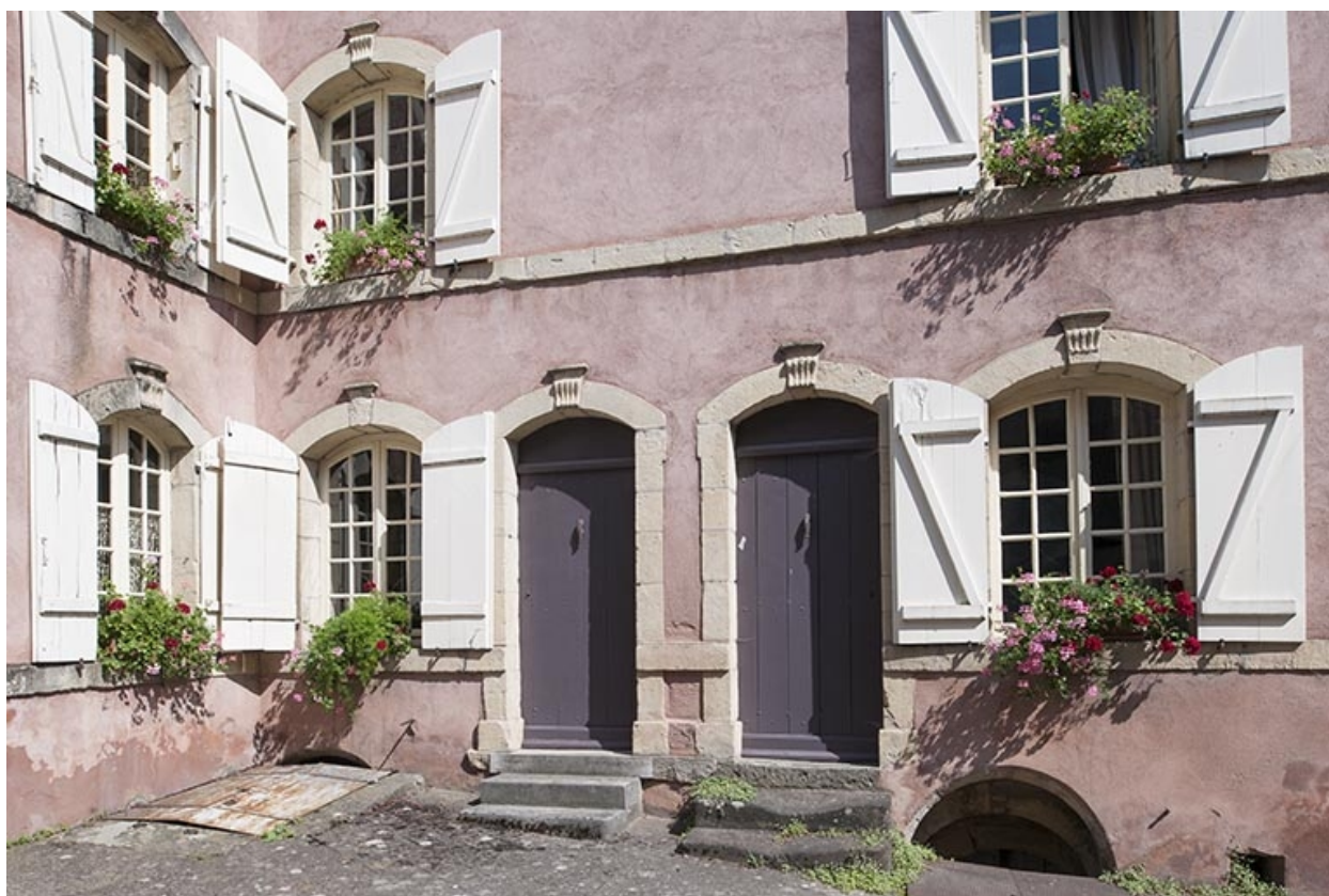
Détail de la façade postérieure, rue Thiers.
