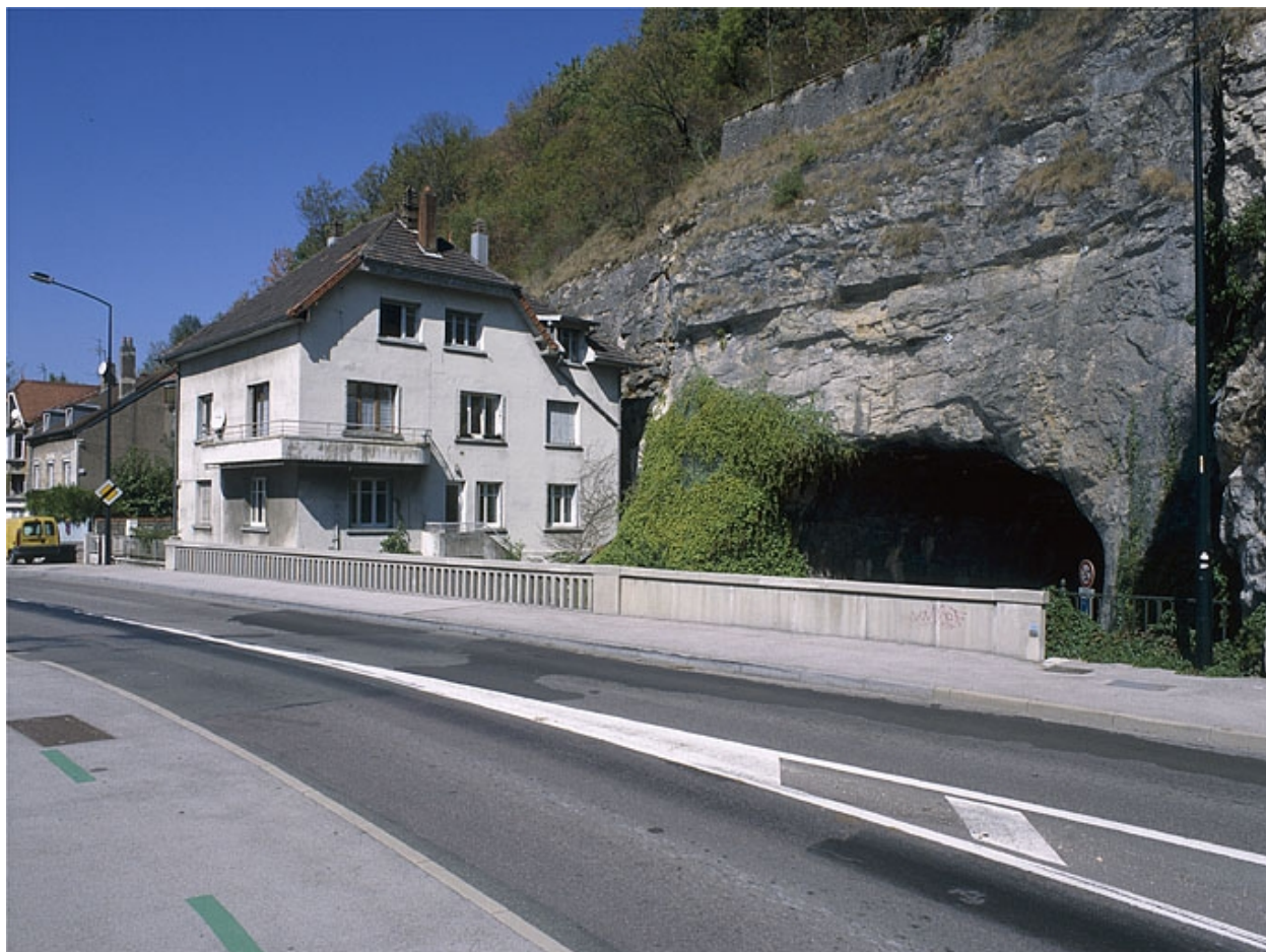
Pont routier et maison d'éclusier.
