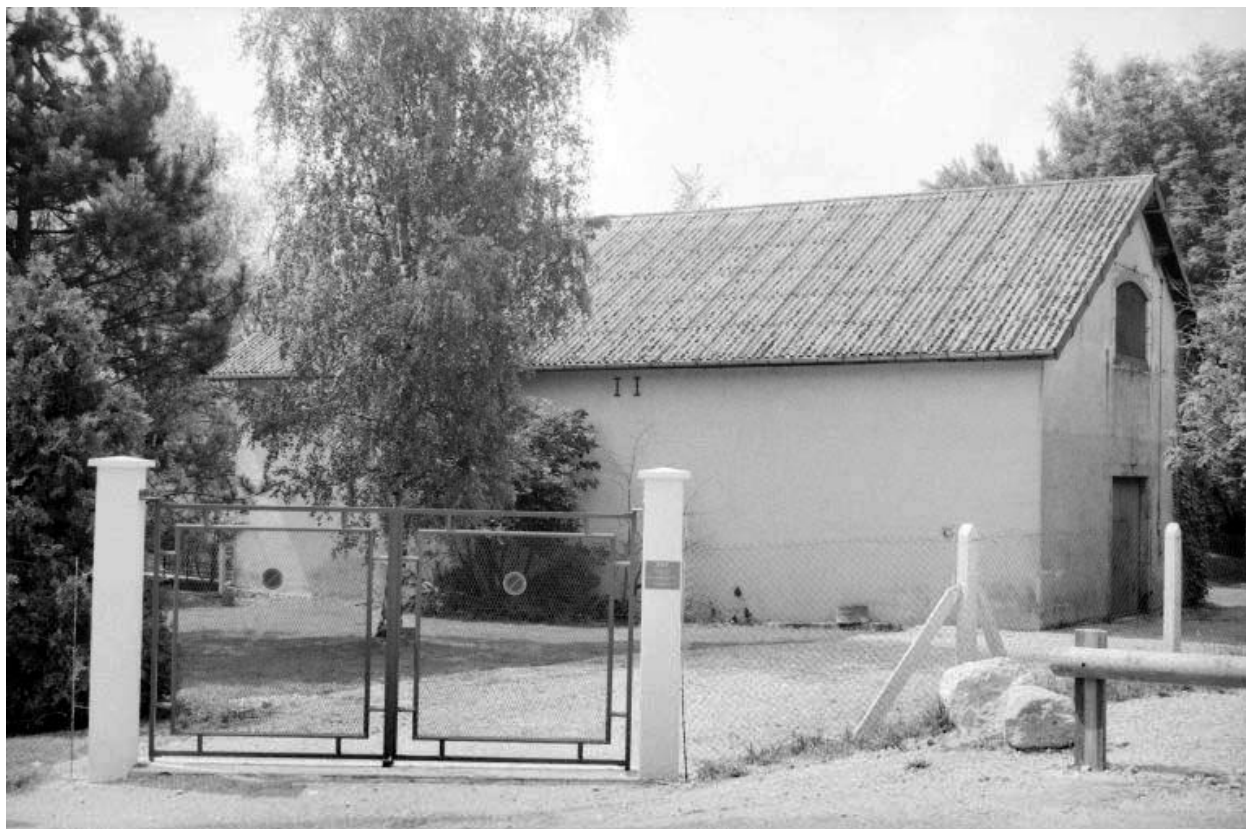
Bâtiment de prise d'eau.
