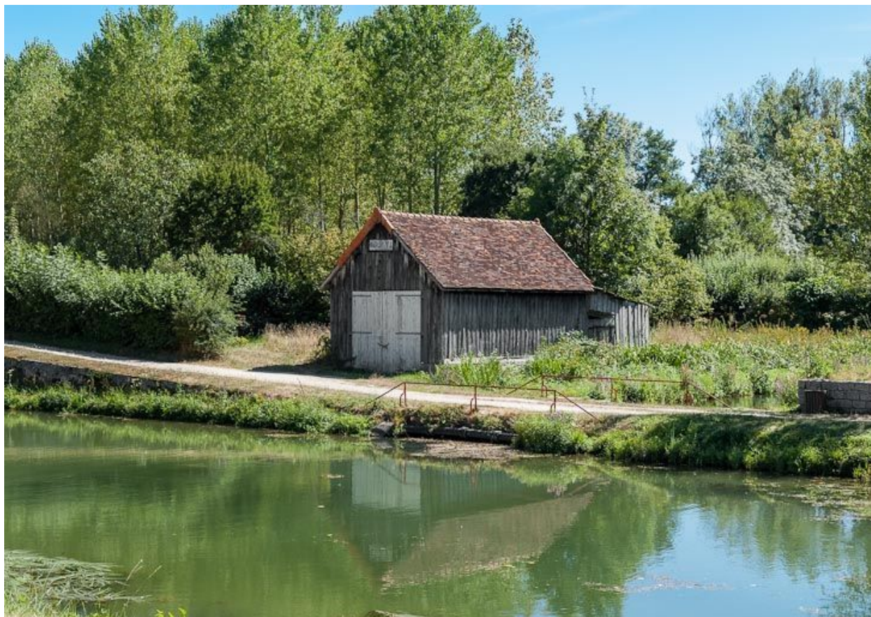
La remise, vue d'ensemble.
