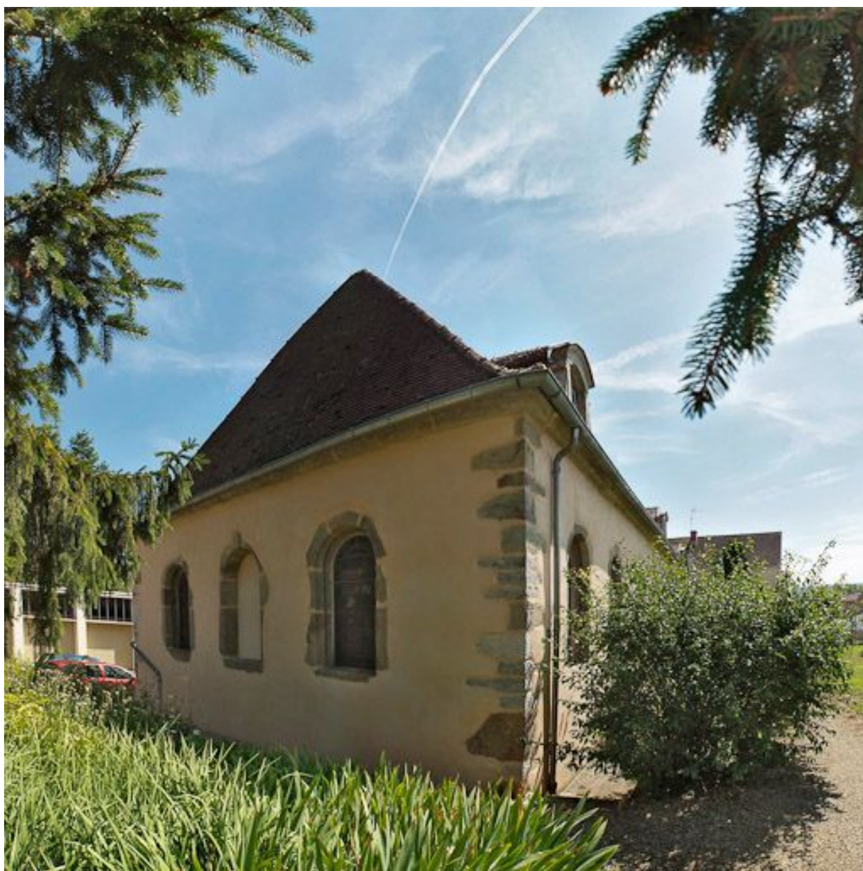
Elévation droite (ancienne chapelle).
