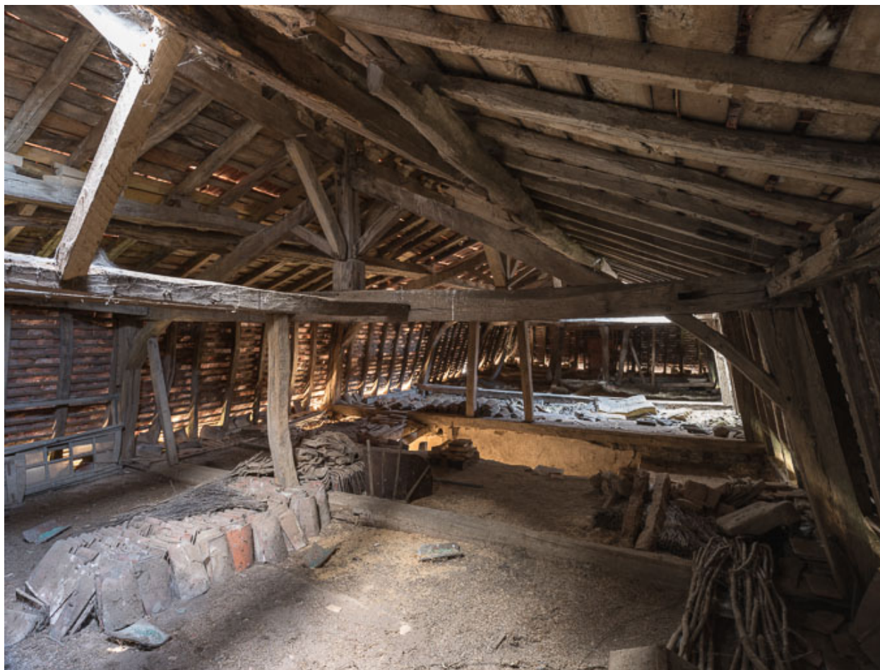
Vue de la charpente de la demeure
