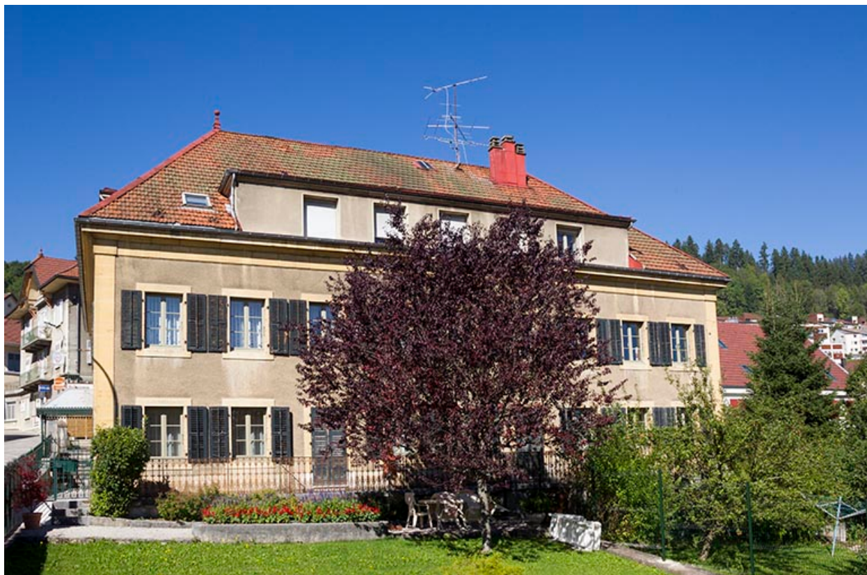
Maison : façade latérale droite.
