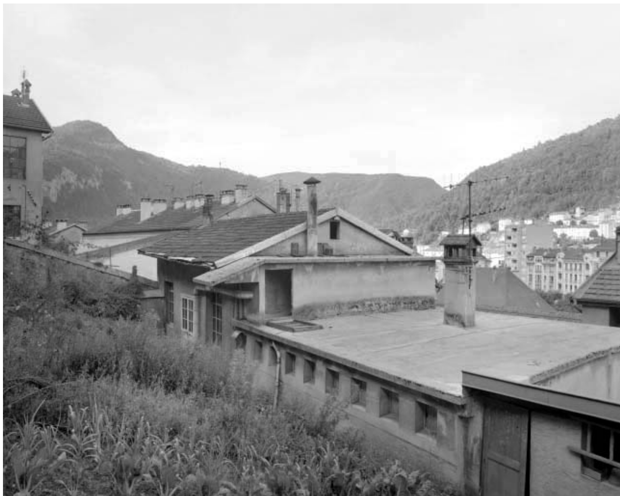
Façade postérieure des ateliers de fabrication.
