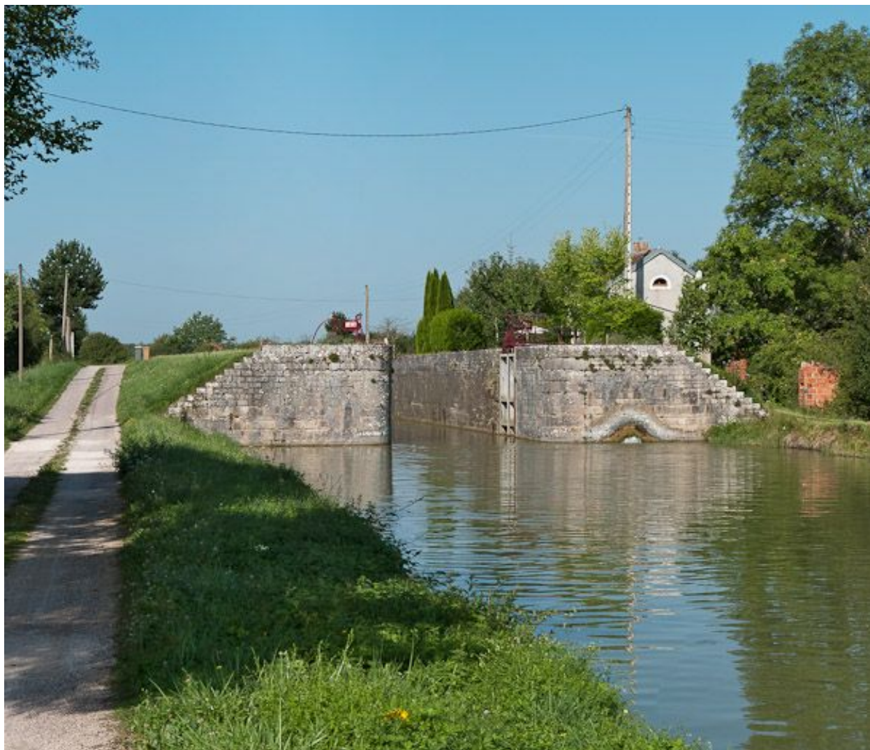
Vue du site d'écluse depuis l'aval.
