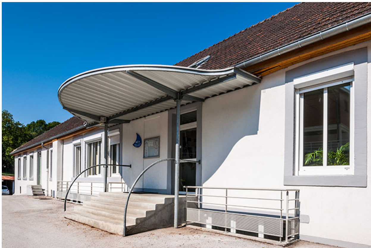
Détail de l'entrée postérieure du bâtiment d'externat.
