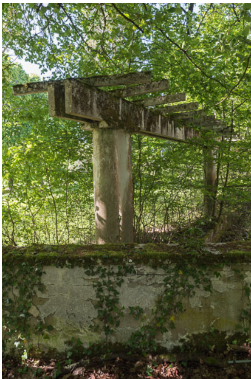
Pergola, vue depuis le nord-est, détail.
