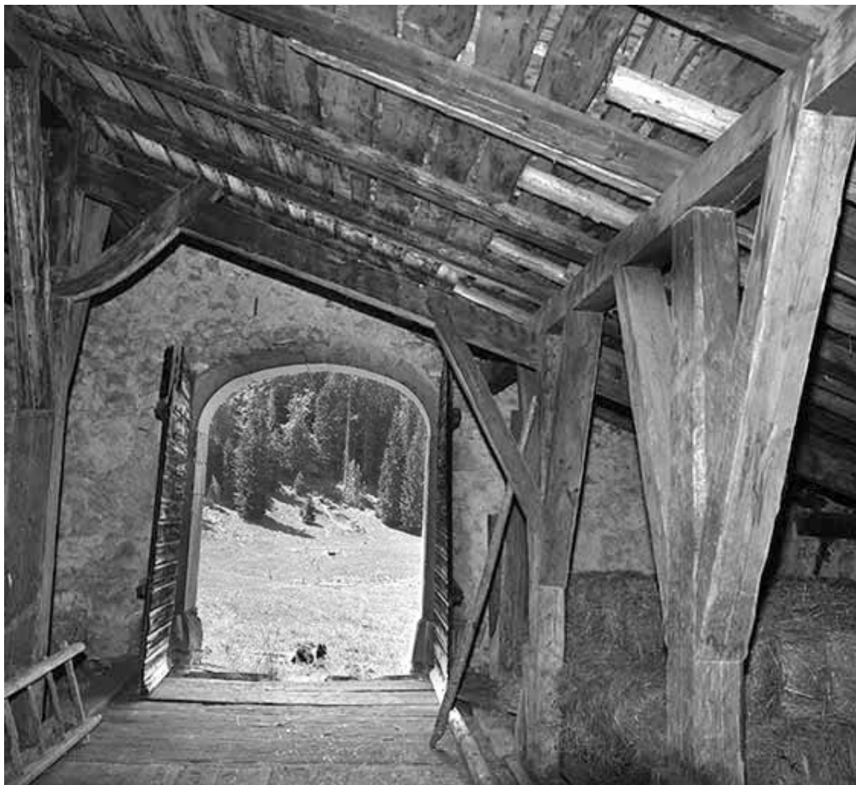
Vue intérieure de la charpente.
