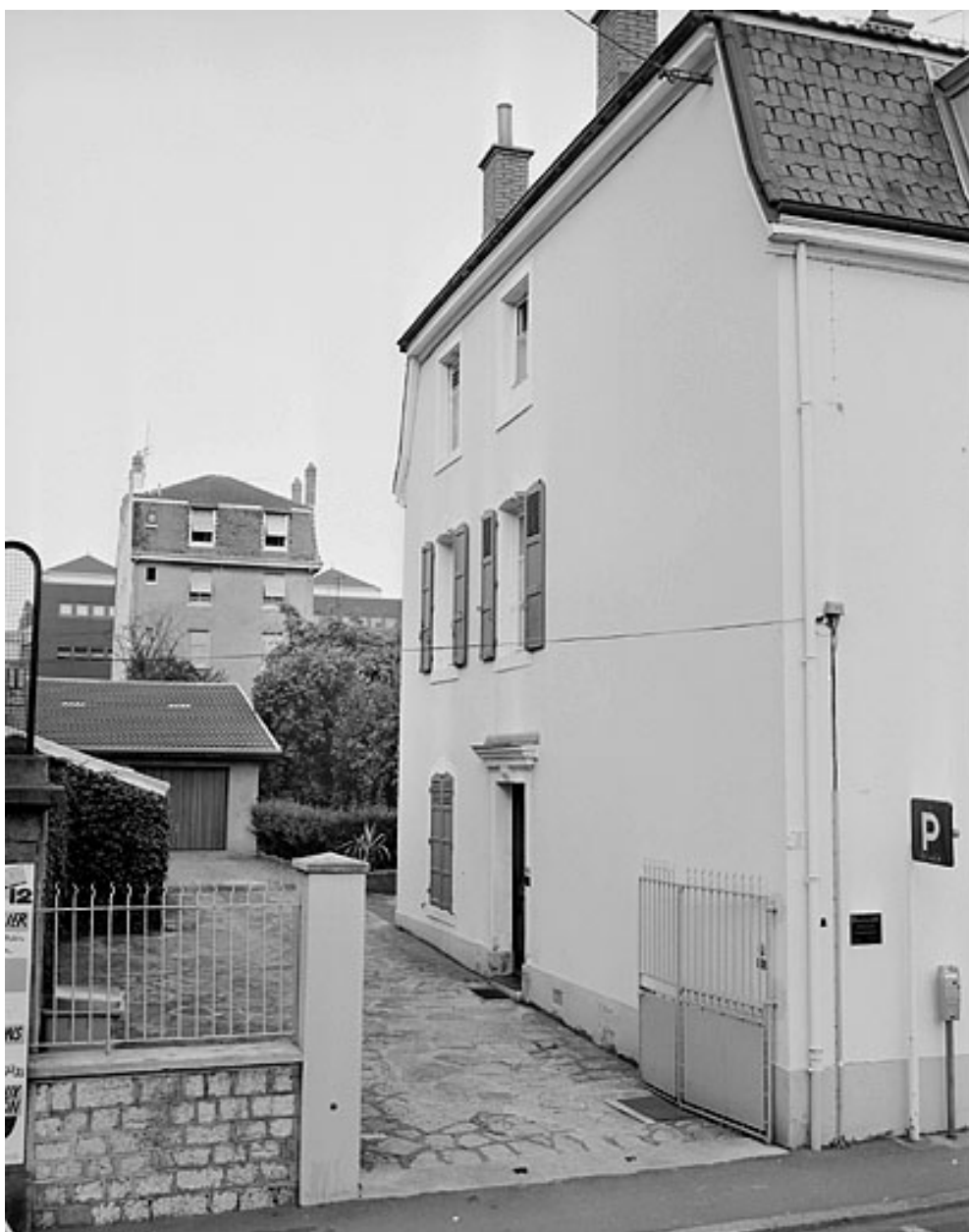
Façade latérale gauche du corps d'habitation.
