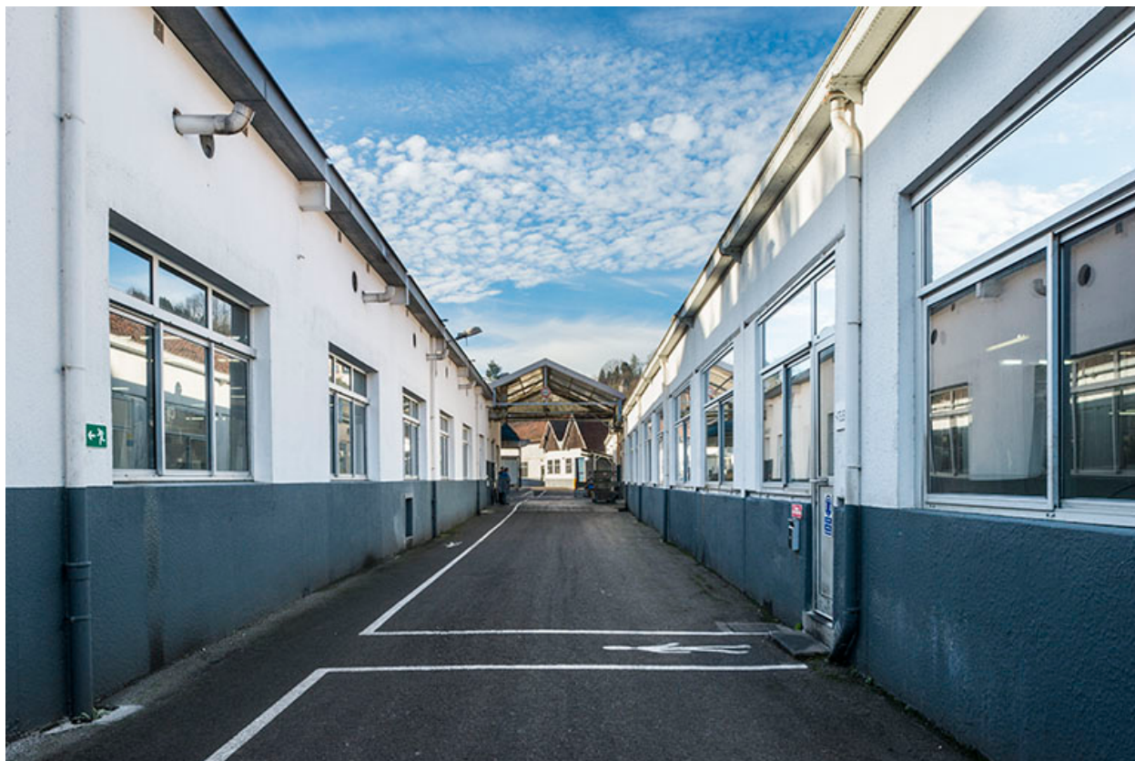
Passage entre deux ateliers. Vue depuis l'ouest.
