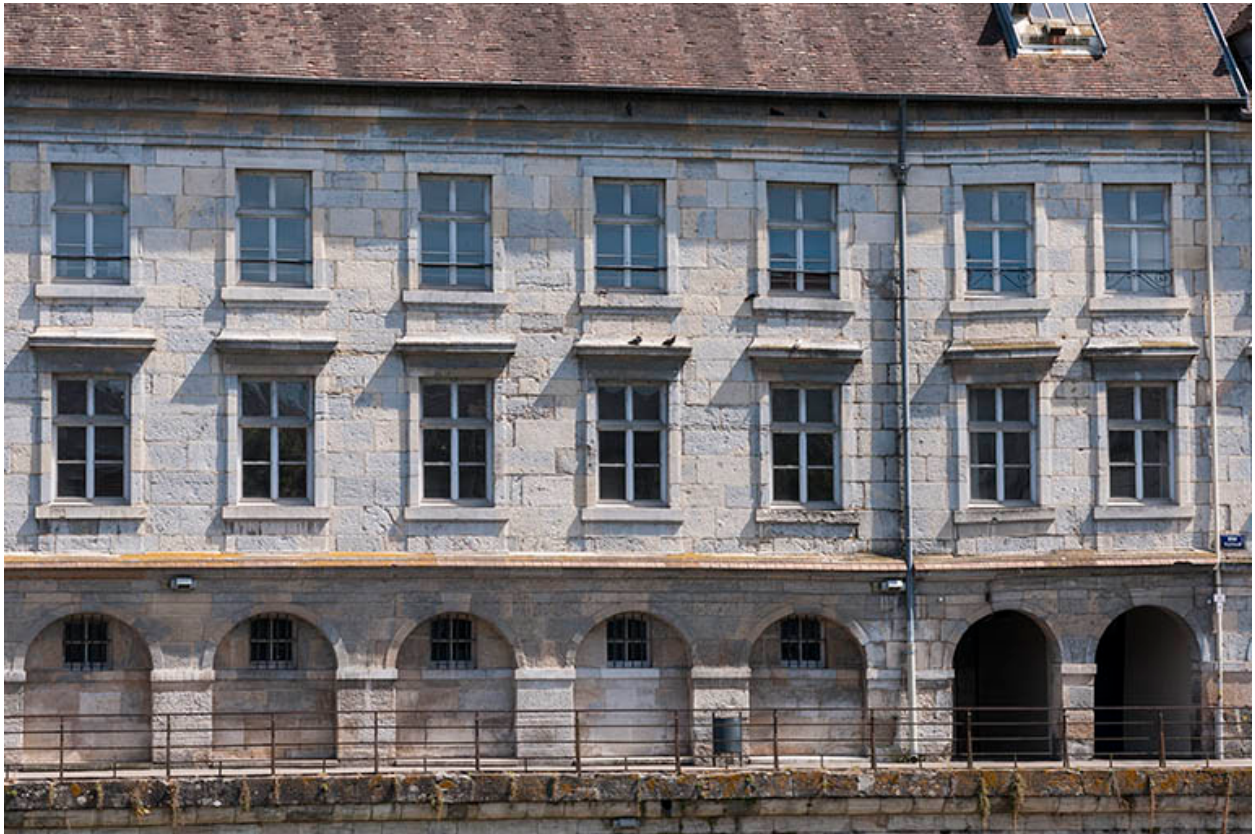
Façade postérieure : partie droite avec débouché du passage couvert sur le quai.
