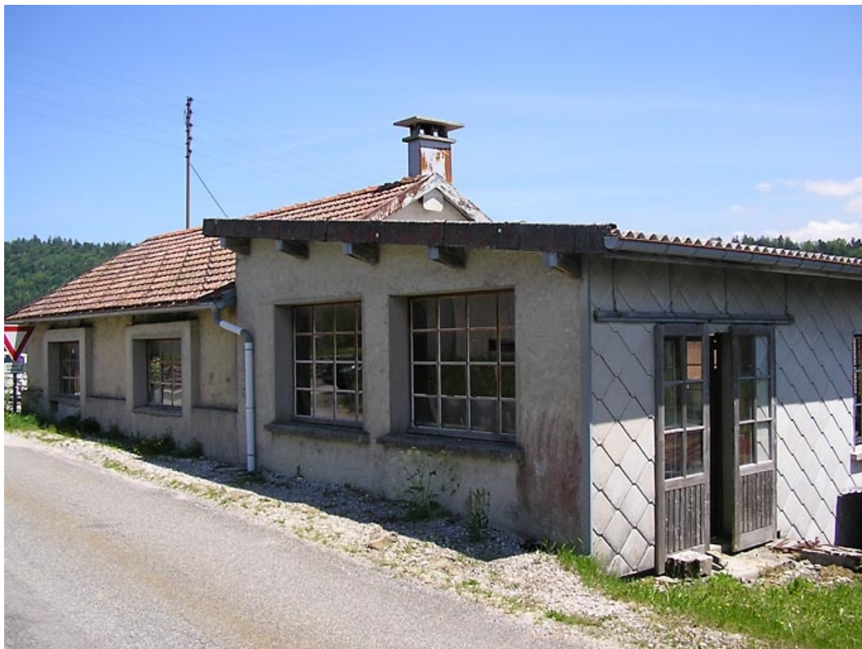
Atelier de menuiserie situé au lieu-dit Prénovel de Bise.
