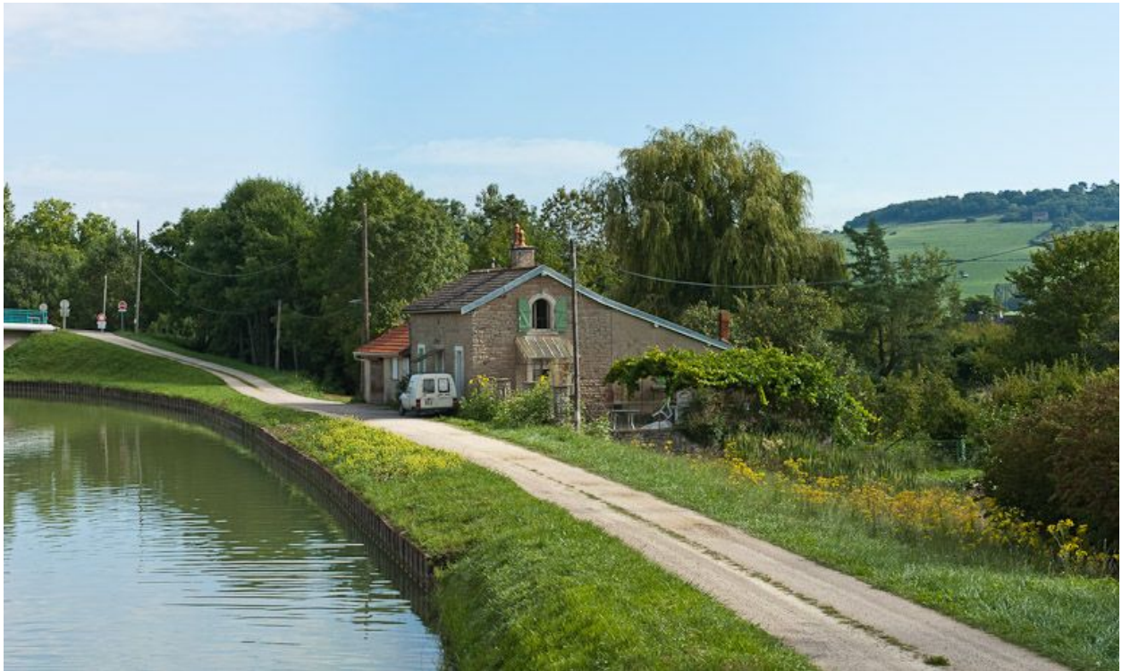
Vue de la maison de garde.
