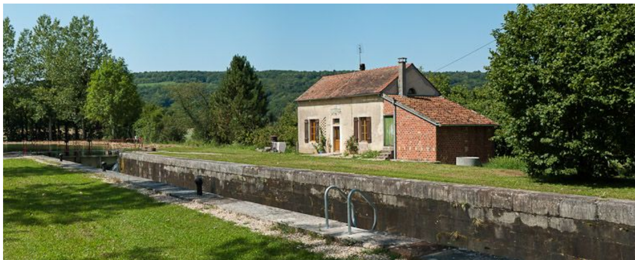
Vue d'ensemble du site d'écluse.
