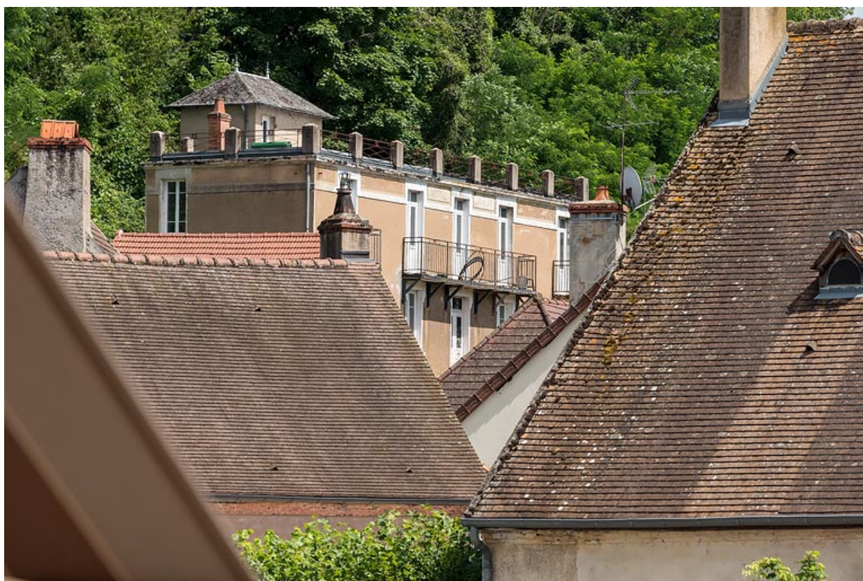
Façade de l'extension ("annexe").
