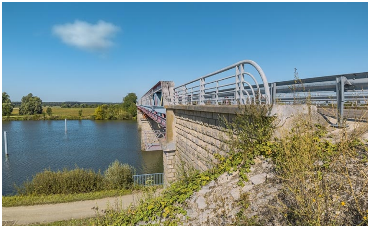
Vue d'ensemble du pont.
