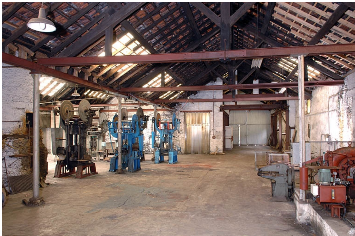
Travée nord-est de l'atelier dit des Balanciers.
