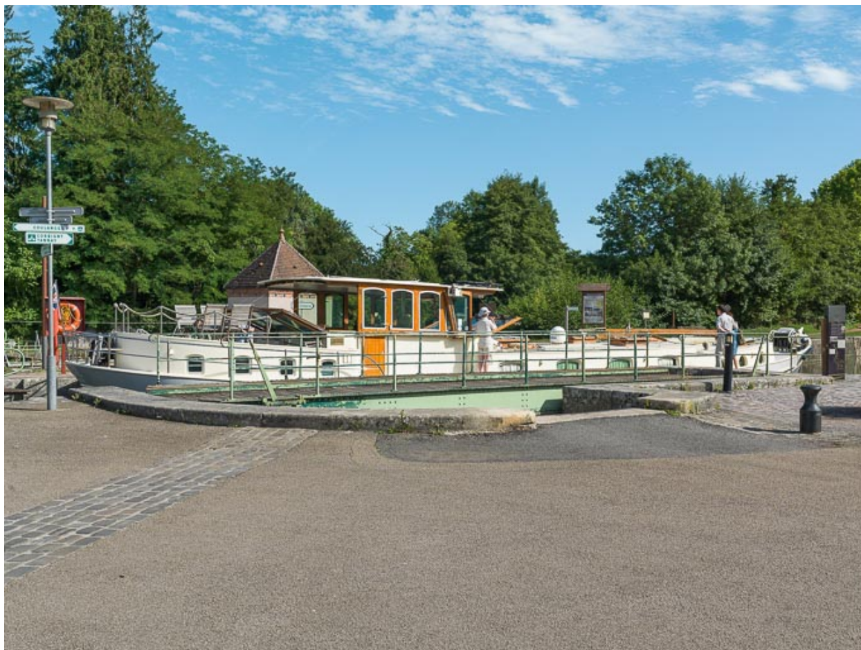
Pont au passage d'un bateau.
