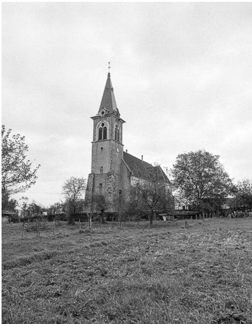
Façades antérieure et latérale droite.
