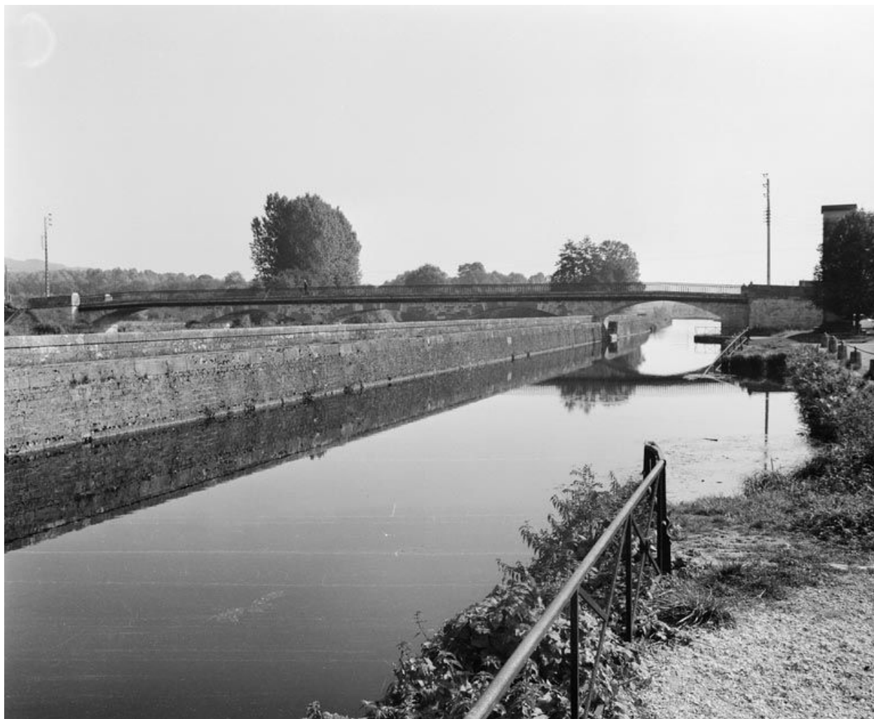
Pont enjambant l'embranchement du canal d'Accolay.
