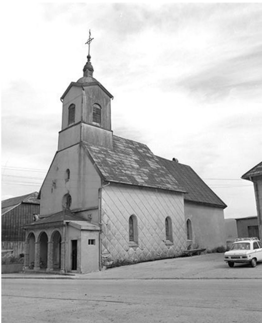
Façades antérieure et latérale droite.
