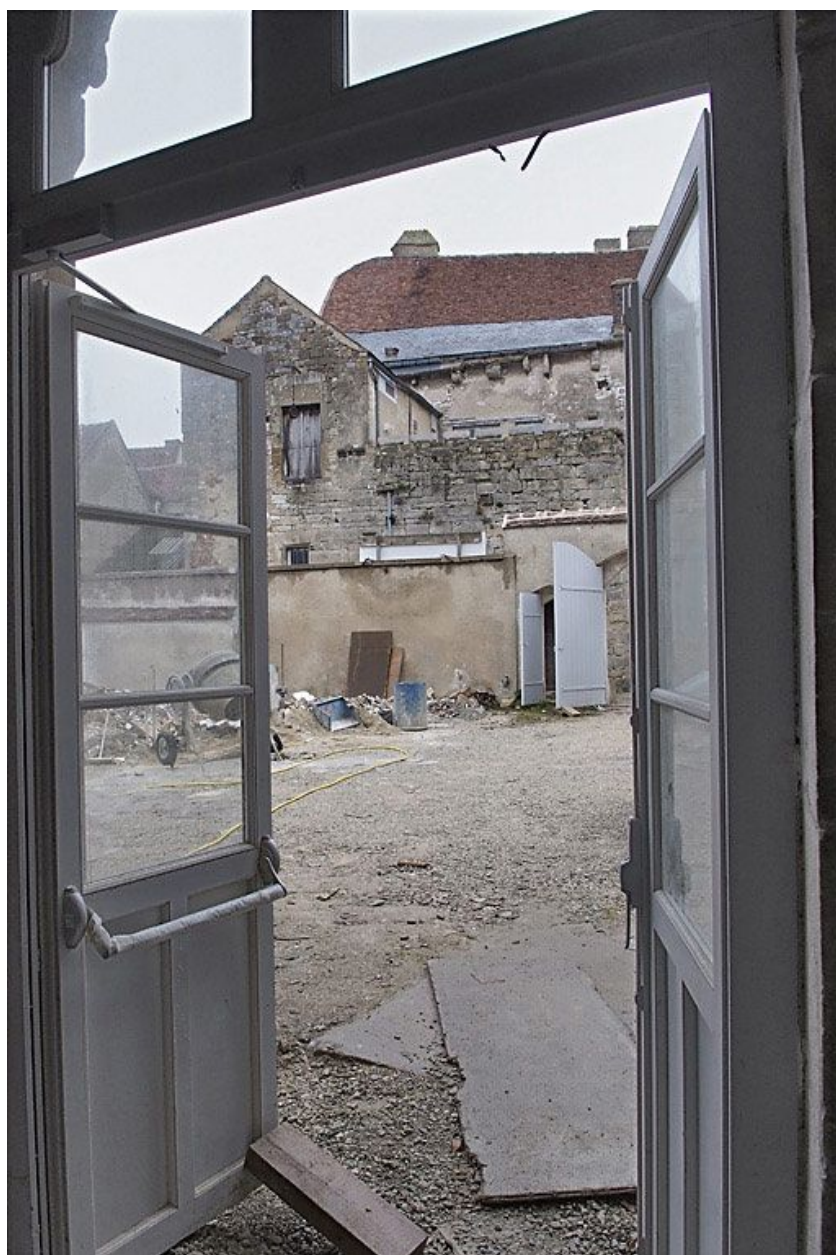
Vue de la cour pendant les travaux.
