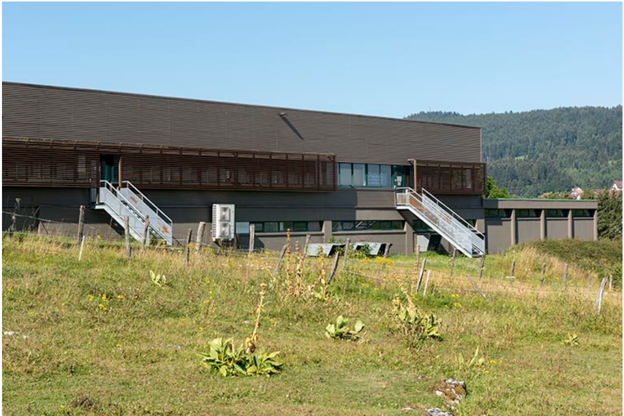
Façade postérieure : escaliers extérieurs vers l'angle nord-ouest.
