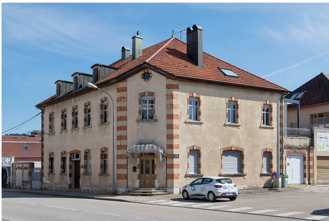
Vue depuis le sud-ouest.
