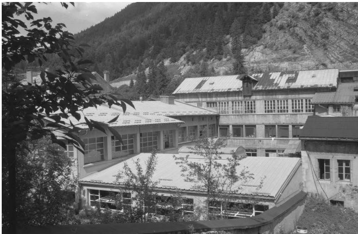
Façade postérieure des ateliers au n° 194.
