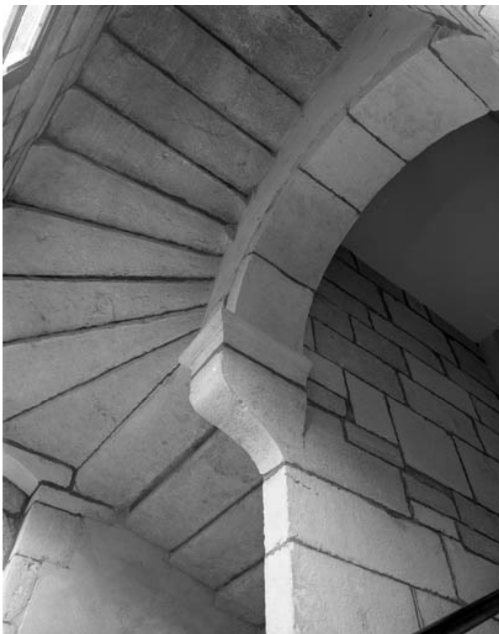
Détail d'une volée d'escalier.
