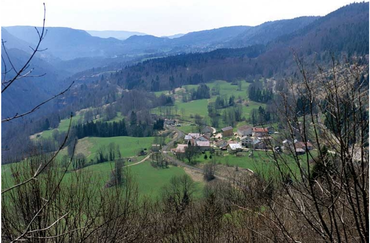
La voie au village de Lézat. PK 058.100 - 058.400.
