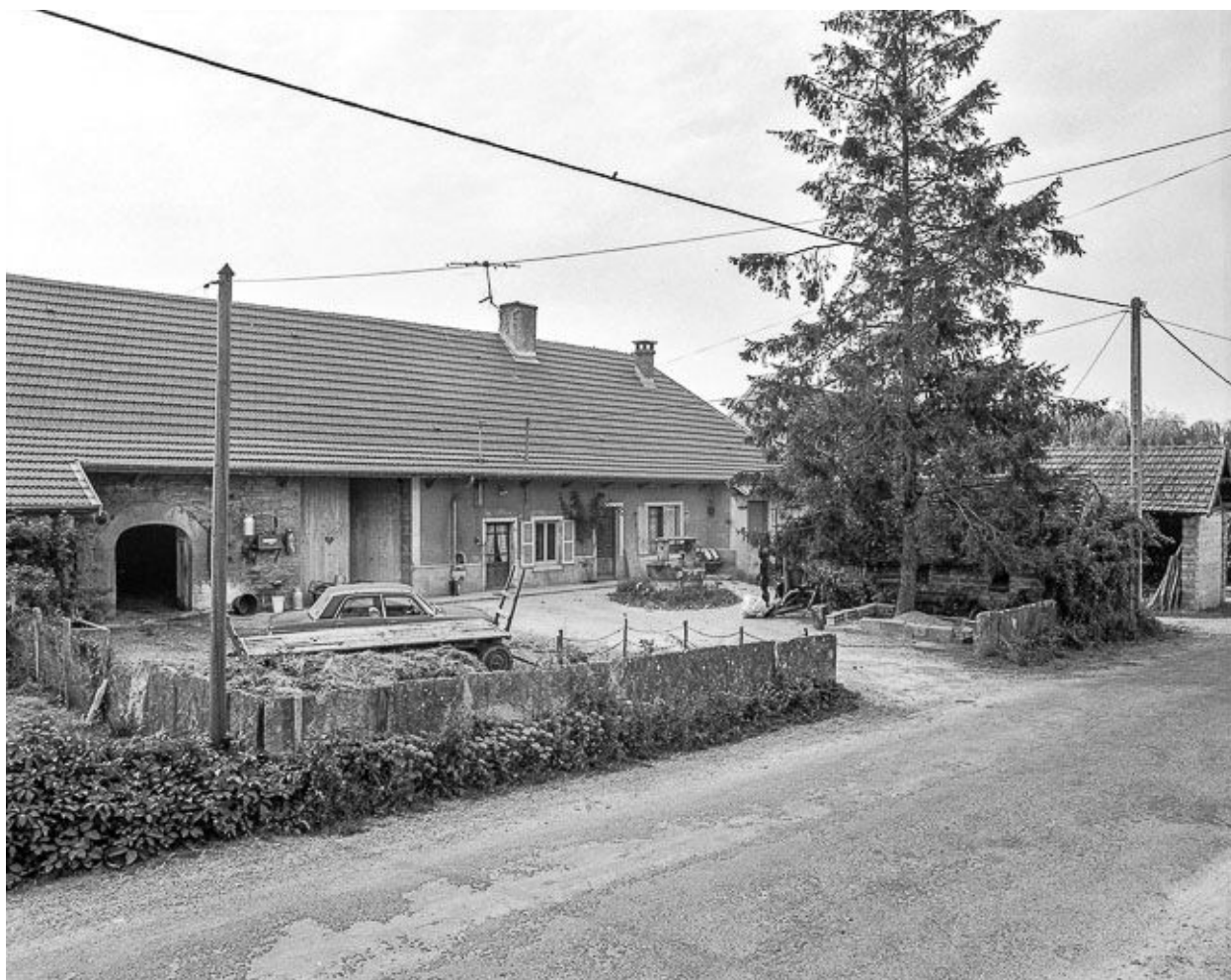
Ferme située rue du Centre.
