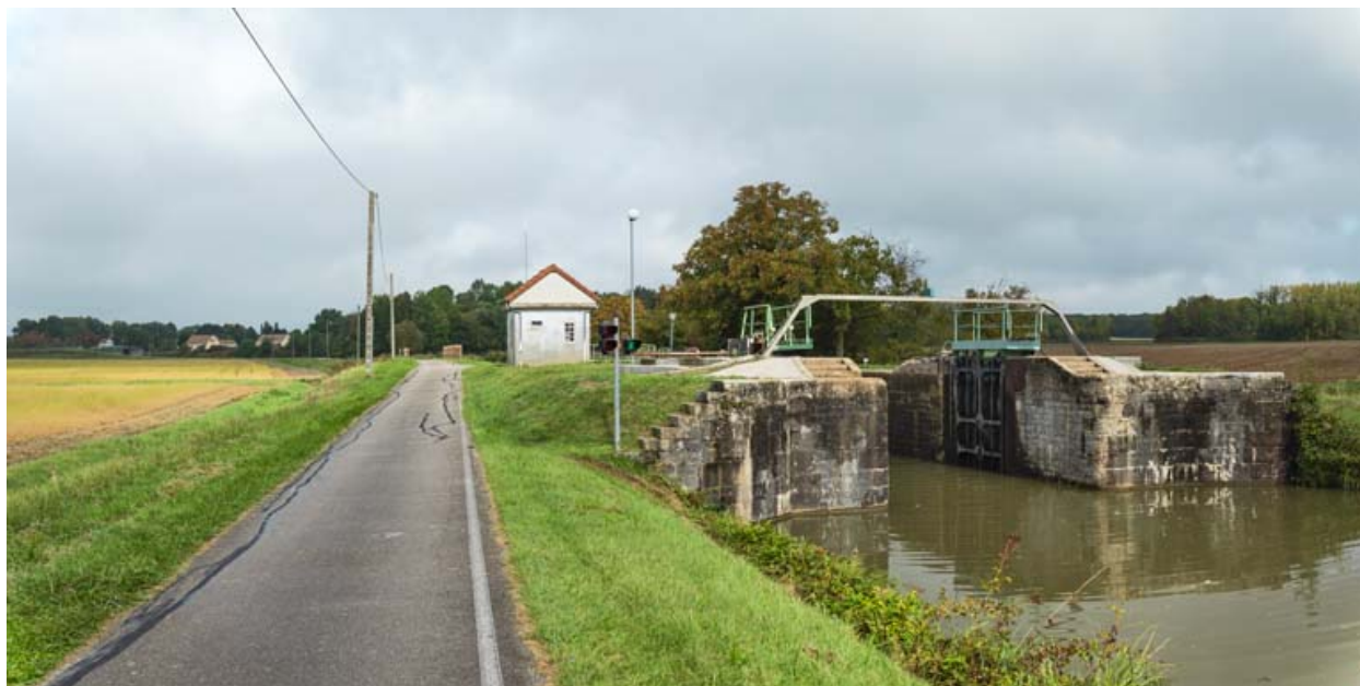
Vue de l'écluse.
