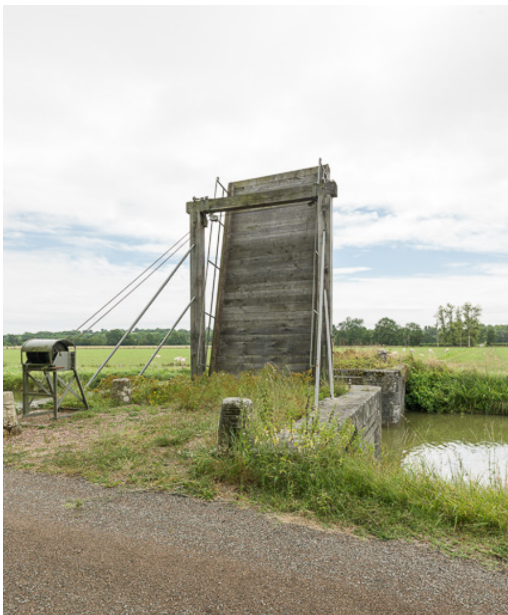
Vue du pont relevé.
