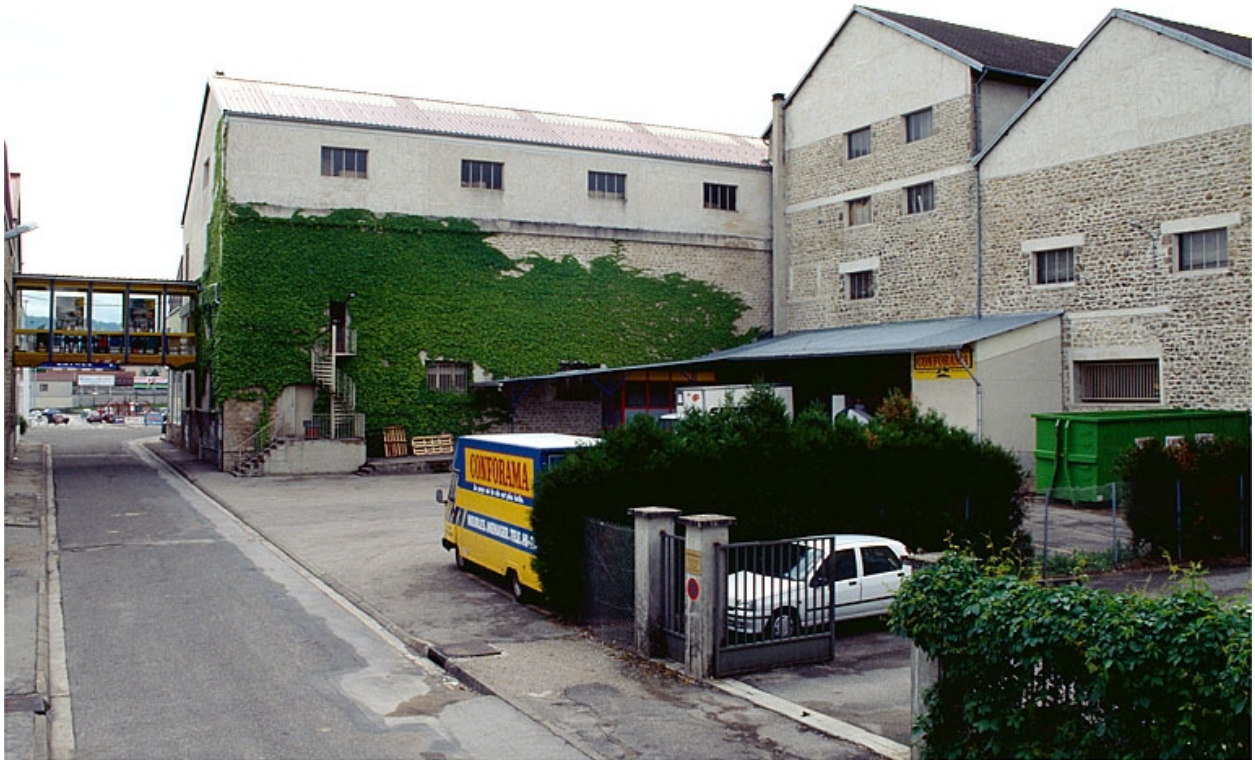
Atelier de fabrication depuis le nord-ouest.
