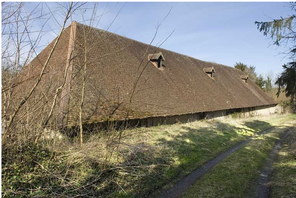
Halle à charbon depuis le sud-est.
