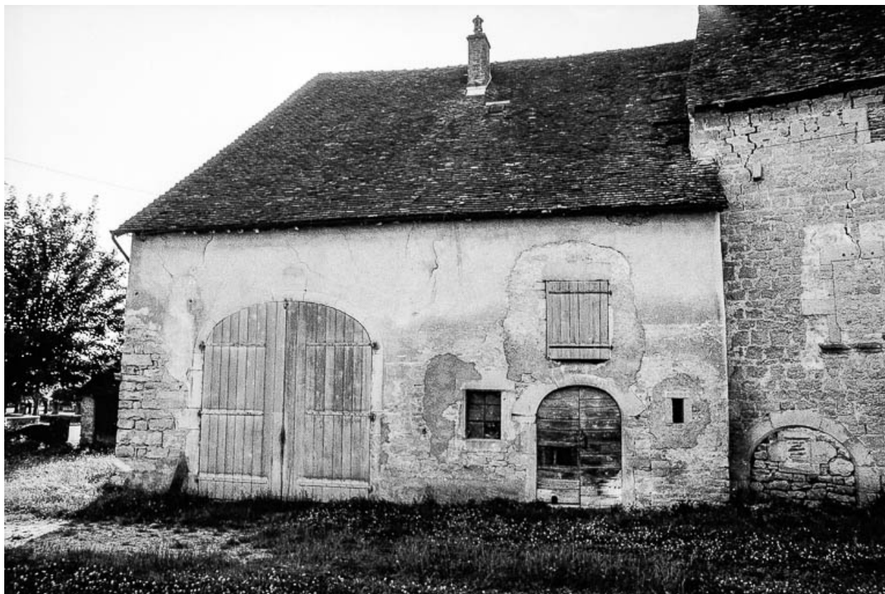
Maison cadastrée 1960 AI 101, située rue du Puits : façade antérieure.
