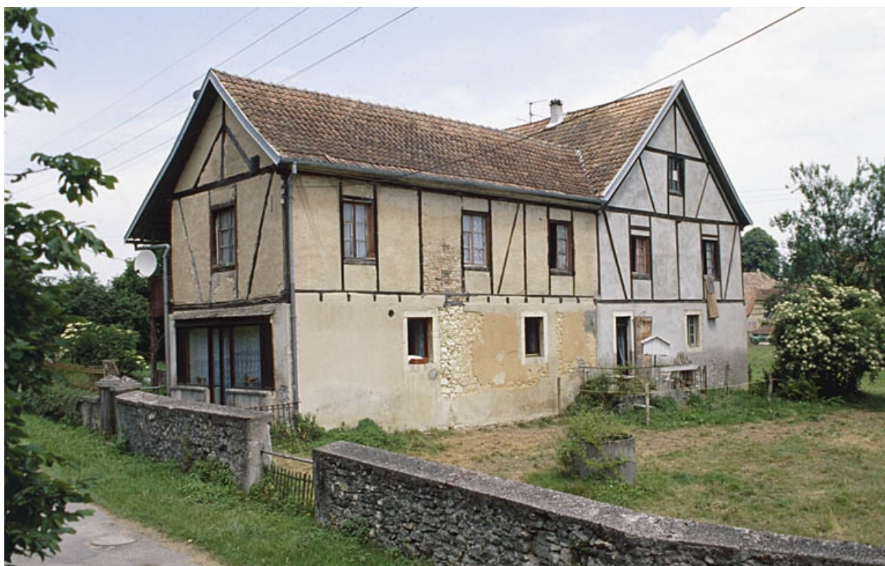
Façade postérieure du logement.
