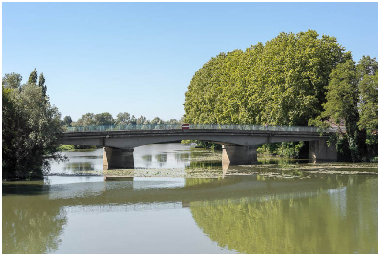
Vue d'ensemble du pont.
