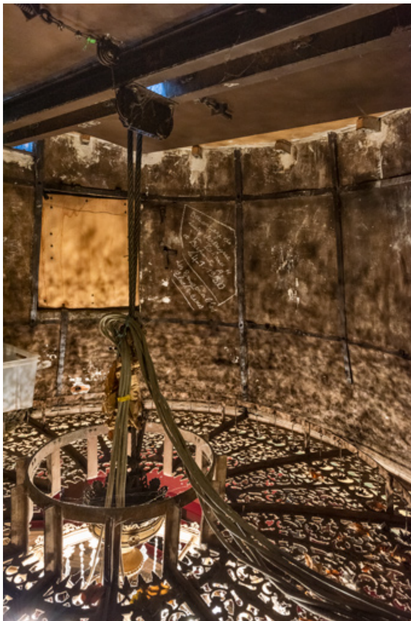
Comble de la salle, cheminée d'aération : intérieur.
