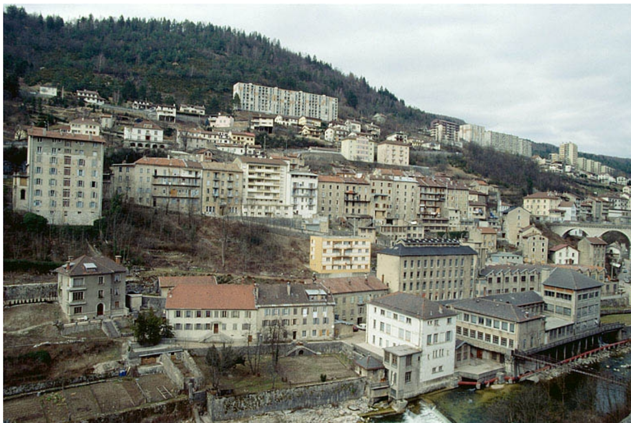
Vue d'ensemble du site depuis le sud-est.
