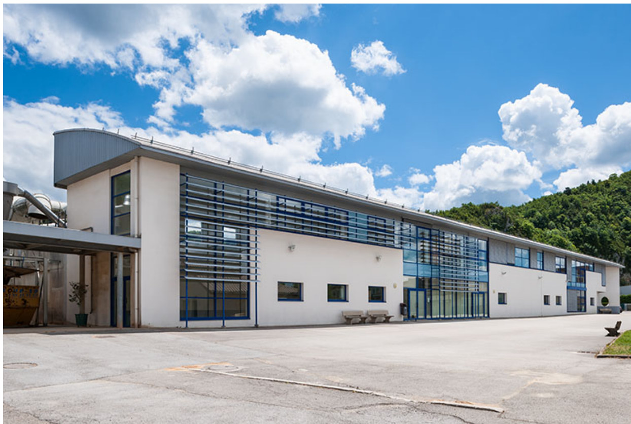
Ateliers, façade antérieure.
