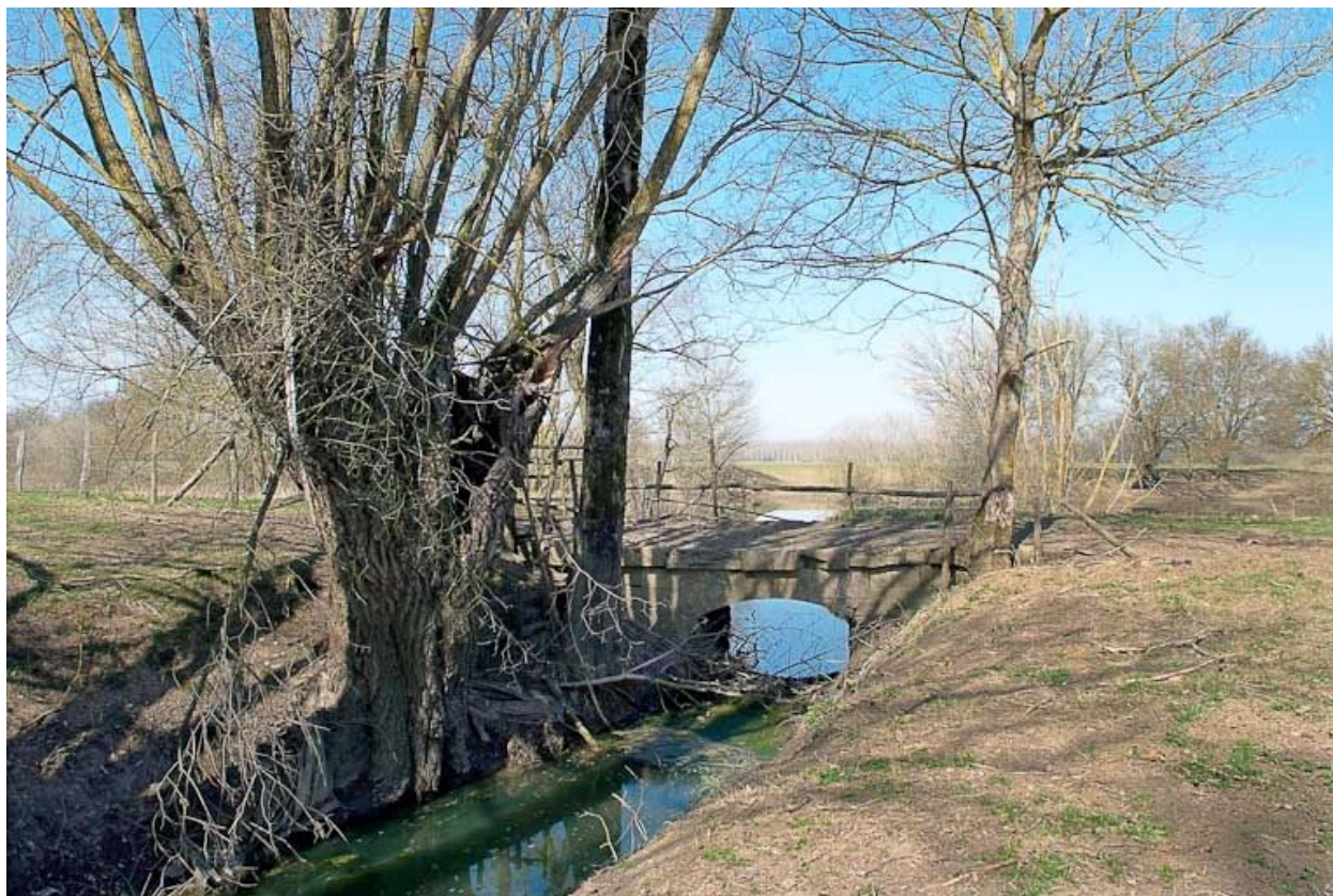
Ponceau : vue d'ensemble.
