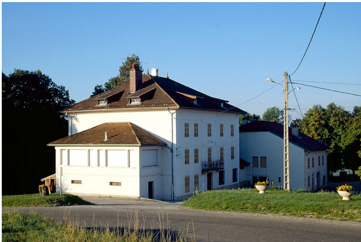
Maison, usine d'instruments de mesure (fabrique de mesures linéaires) et de lunetterie Tournier Frères, Longchaumois.
