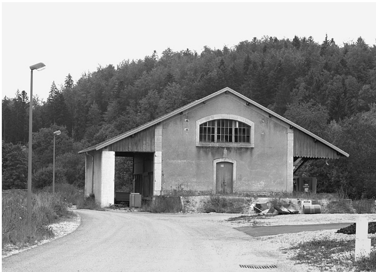
Entrepôt : façade antérieure (nord).
