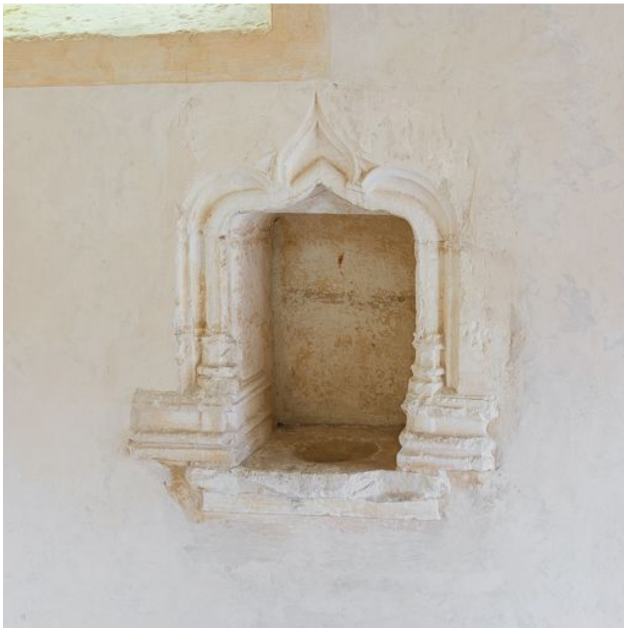
Vue du lavabo, mur droit.
