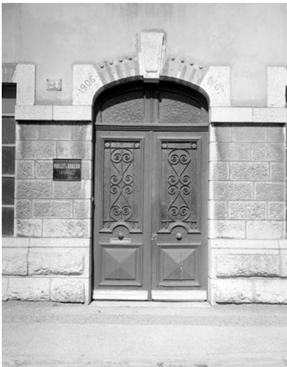
Porte d'entrée du 1er bâtiment.
