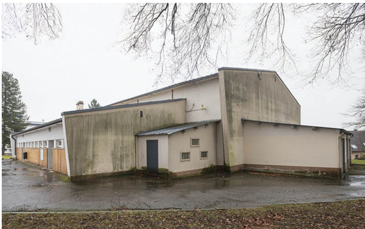
Angle nord-ouest du gymnase.
