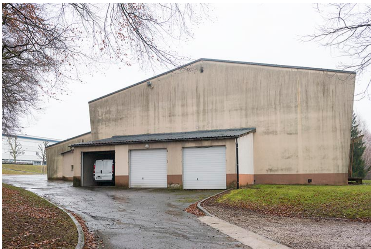
Façade postérieure - ouest - du gymnase.
