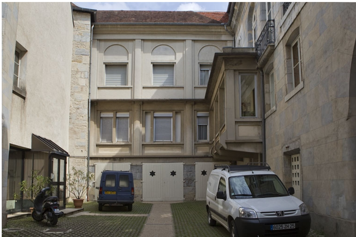
Vue d'ensemble de la cour postérieure.
